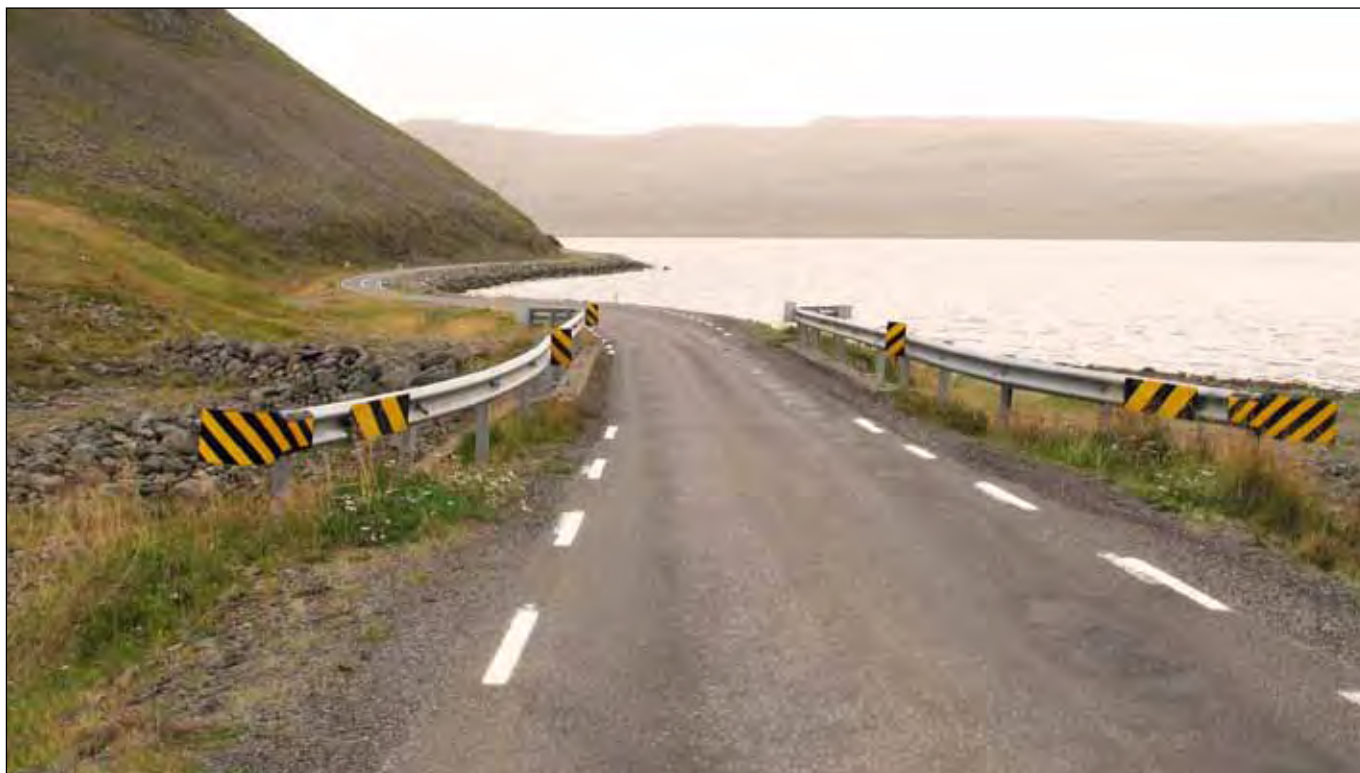
Varasöm einbreið brú á Raknadalsá í Patreksfirði (Barðastrandarvegur 62) er ein fjögurra brúa sem verða endurnýjaðar í átaksverkefni skv. tillögu Vegagerðarinnar.
